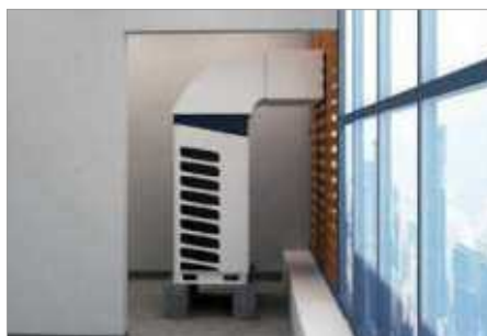
Instalación del conducto
