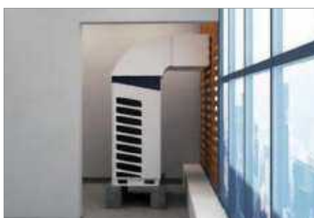
Instalación del conducto
